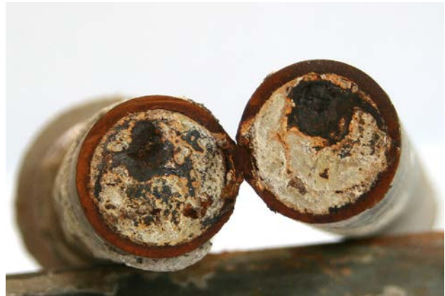
Przekrój niedrożnego przewodu z instalacji c.w.u. z osadami kamienia kotłowego Fot. WJ
